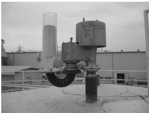
شکل (۳): نصب اشتباه جاذب CO_2 و وکیوم بریکر (چپ) و نقشه صحیح نصب آن (راست)
