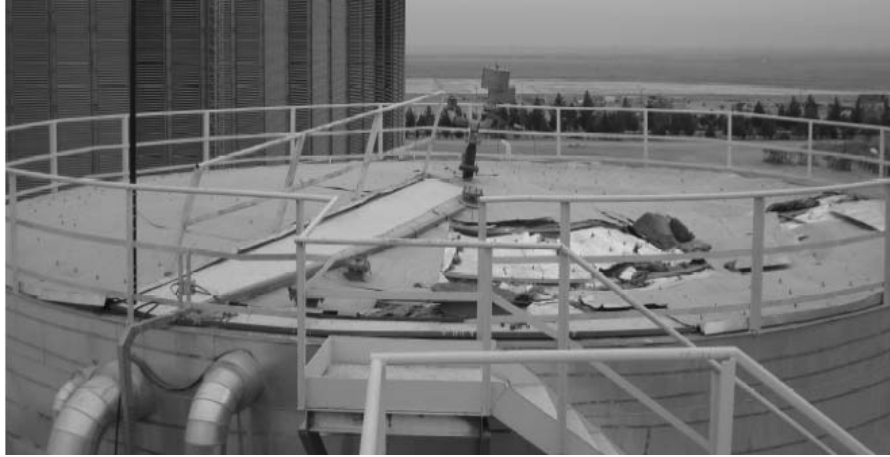
شکل (۲): آسیب دیدگی سقف مخزن نیروگاه سیکل ترکیبی یزد
