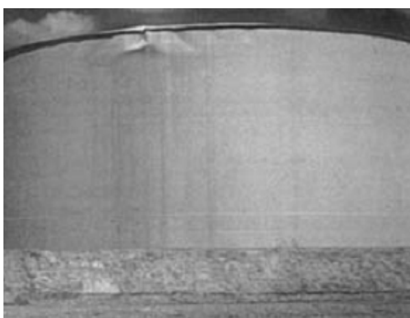
شکل (۵): تانکری که در هنگام تخلیه دچار حادثه شده است (راست) و مخزنی که در اثر پر شدن بیش از حد آسیب دیده است (چپ).
