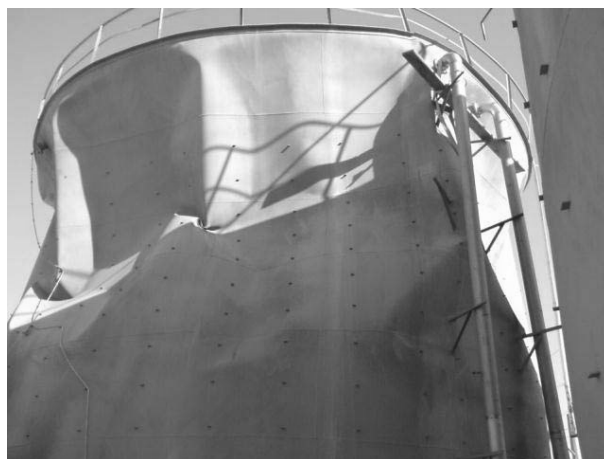
شکل (۴): فروپاشی مخزن ذخیره آب دمین نیروگاه کرمان در اثر خلاء
